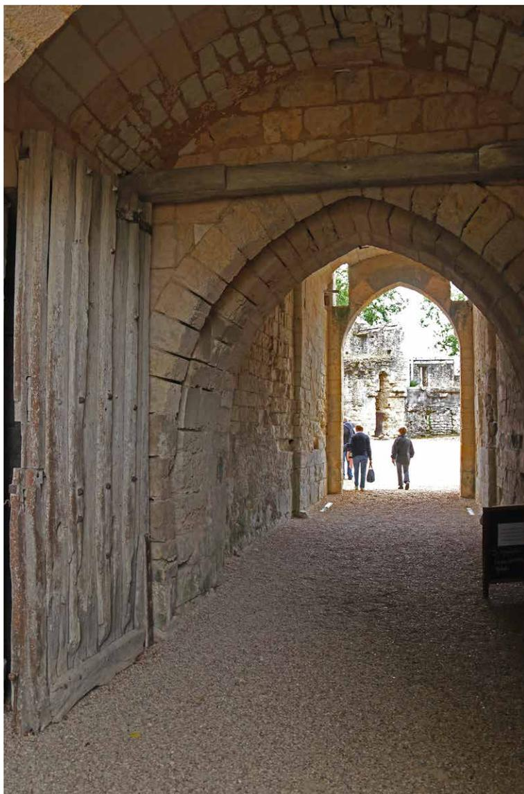
Fig. 13 – Montreuil-Bellay, château, vue intérieure du couloir d'entrée, prise vers le sud. Au premier plan, l'entrée du début du XIII<sup>e</sup> siècle ; au second plan, le long couloir du châtelet construit par Guillaume d'Harcourt.
