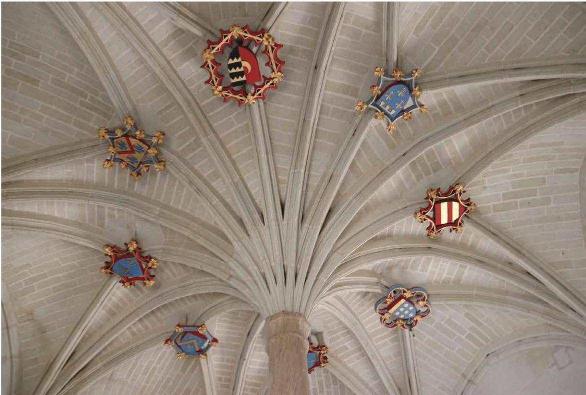
Fig. 25 – Montreuil-Bellay, château, voûte en palmier de la grande vis.
