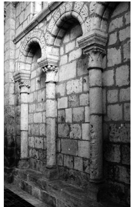
Fig. 9 - Châteaudun, église de la Madeleine, arcature basse.
