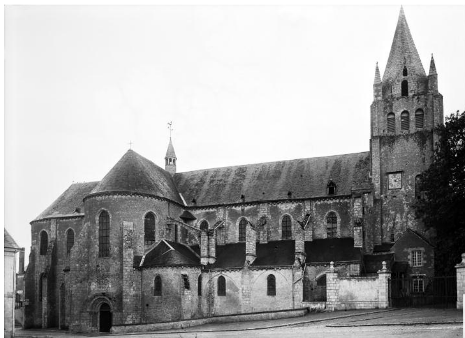
Fig. 4 - Meung-sur-Loire, église Saint-Liphard, vue prise depuis le nord-ouest au début du XX e siècle (Médiathèque de l'Architecture et du Patrimoine).
