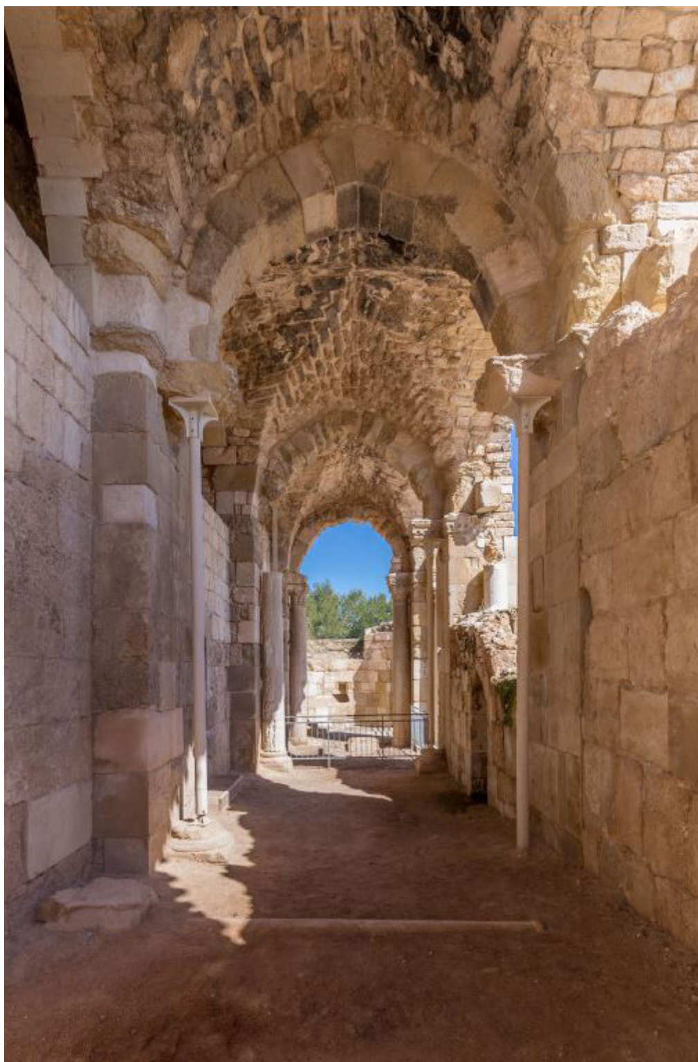
Fig. 37 : Bethgibelin - Beit Guvrin. Bas côté nord de l'église (après 1168).
