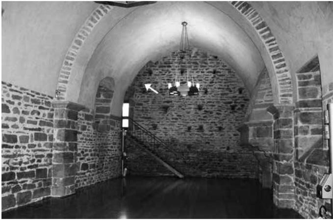
Fig. 25 - Verrès, extrémité nord de la grande salle. Au fond un escalier moderne remplace la rampe basse, alors qu'une deuxième rampe menait à l'escalier mural marqué d'une flèche.
