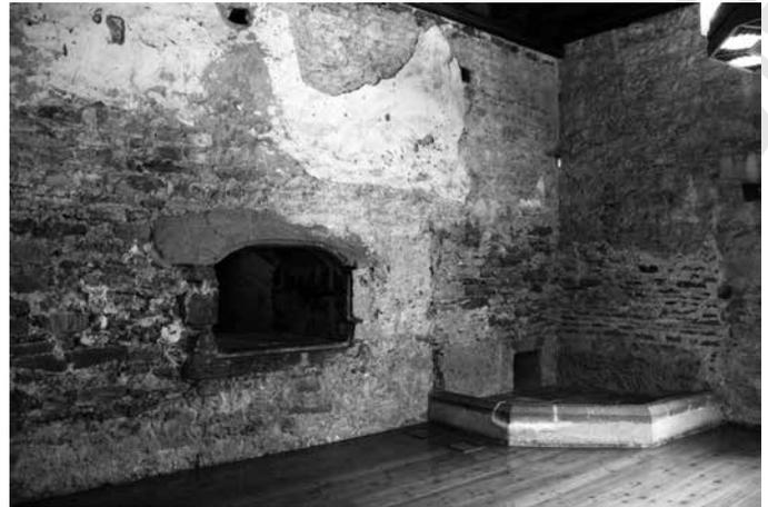
Fig. 32 - Verrès, grande salle haute, le passe-plat et la plate-forme du poêle alimenté par une cheminée dans la cuisine.
