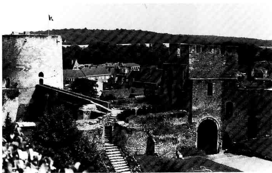
Fig. 14. — Le secteur de la Basse-Cour sud-est, vu depuis la motte. De gauche à droite, la Tour du Prisonnier (13), l'accès au secteur du Gouverneur (18), les restes du bâtiment nord (17), la Porte du Gouverneur (16).
