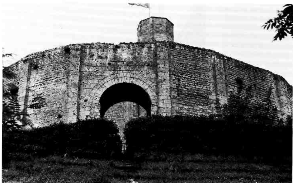
Fig. 1. — L'entrée principale de la chemise sur motte ( i ), vue depuis le sud.
