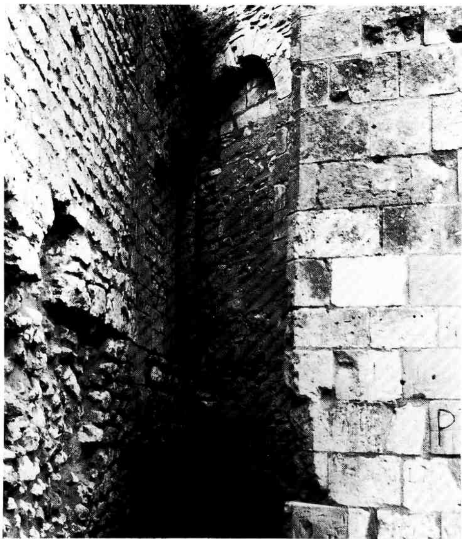
Fig. 8. — Vue du raccord e entre la tour maîtresse et la chemise au nord-ouest. Noter l'arcature ménagée pour laisser place à l'accès au couloir d .
