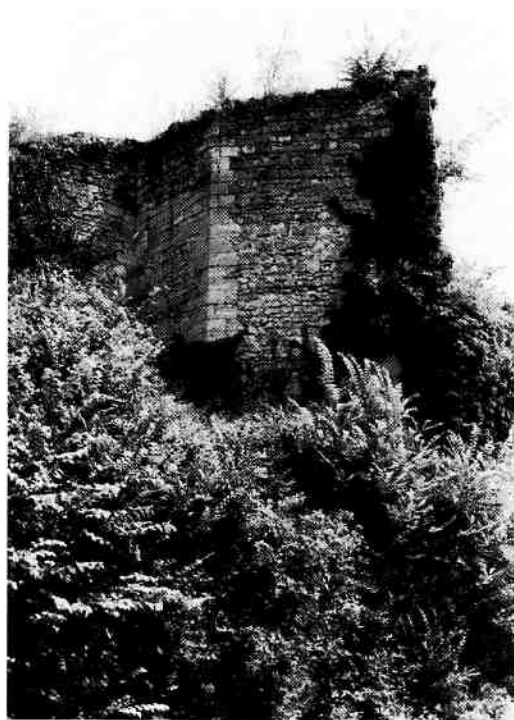
Fig. 10. — La tour 3, vue depuis le nord-ouest.
