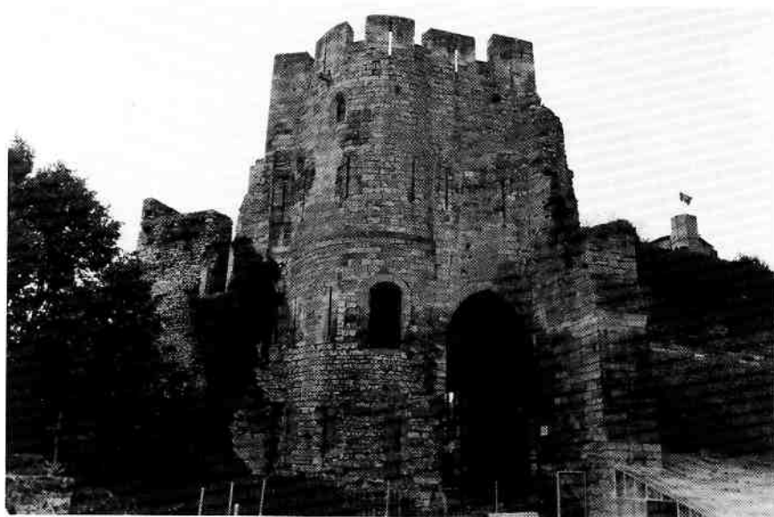
Fig. 16. — La Porte du Gouverneur vue depuis la Basse-Cour, au sud-est.
