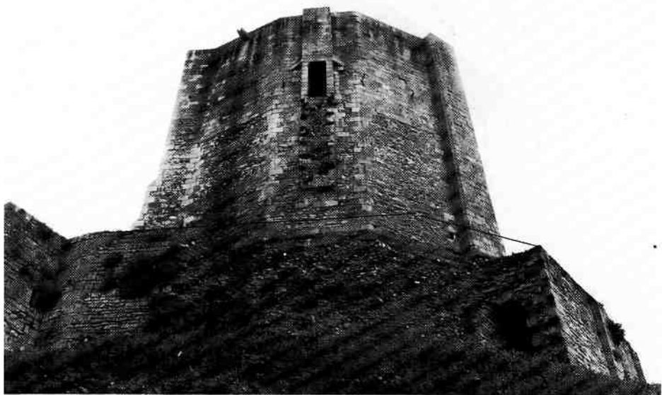
Fig. 2. — Vue de l'ensemble tour maîtresse-chemise depuis le nord. On remarque à gauche les restes de la tour a , à droite le départ du couloir d , et entre les deux la partie disparue de la chemise. Voir également, dans les parties hautes de la tour maîtresse, la porte de l'ancienne latrine.
