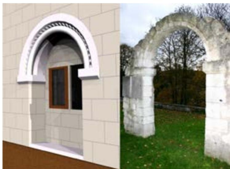
**Figure 25 : Restitution d'une arcade du rez-de-chaussée, et vue actuelle de l'arcade remontée**
