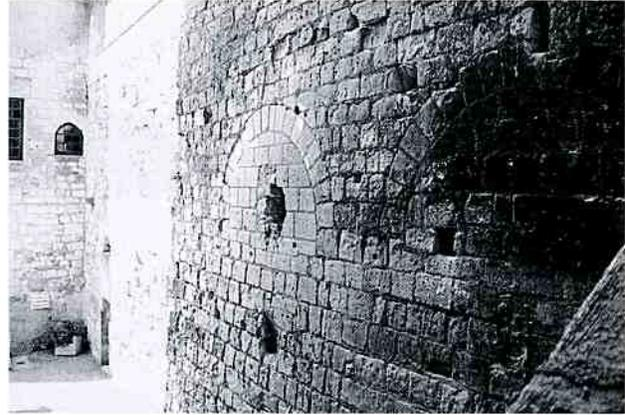
FIG. 4. - *Le mur nord de la chemise vu de l'intérieur, avec ses arcades bouchées.*
