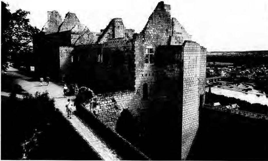
111. CHINON (Indre-et-Loire). Vue des logis royaux. De droite à gauche, la tour de latrines attenante aux chambres royales, le bâtiment contenant les chambres royales et chambres de parement, la grande vis dans une tour carrée, les logis primitifs. Le dernier pignon sur la gauche est celui de la grande salle.
