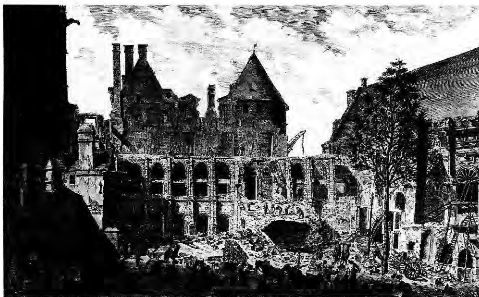
VUE DE LA DÉMOLITION DU PALAIS, TELLE QU'ELLE ÉTOIT A LA S T JEAN DE L'ANNÉE 1777. Dessiné par Thiery.
