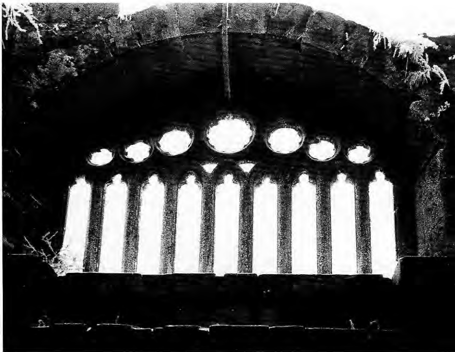
124. NIEDERBRONN-LES-BAINS (Haut-Rhin) : Château de Wasenbourg. Vue intérieure de la fenêtre à sept lancettes, de la première moitié du XIV e siècle.
