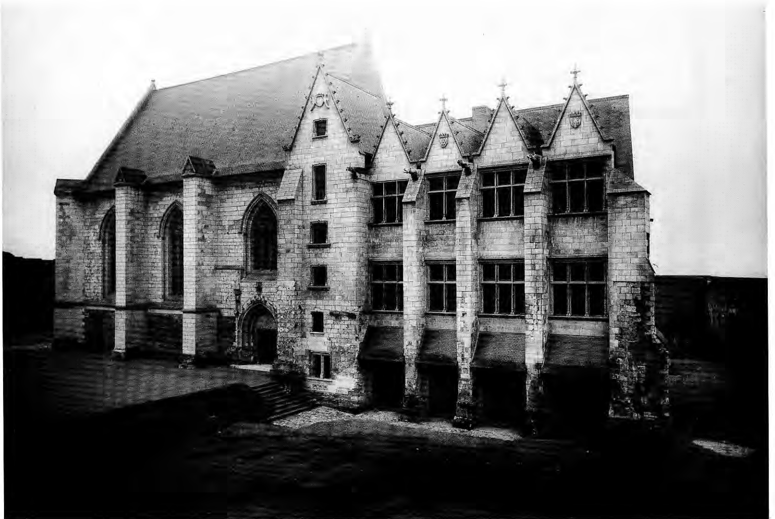
178. ANGERS (Maine-et-Loire). Palais ducal. Vue de la galerie formant couloir ajoutée par René d'Anjou au logis de Louis II d'Anjou (après restauration des années 1950) (Cl. M.-H. SPADEM).
