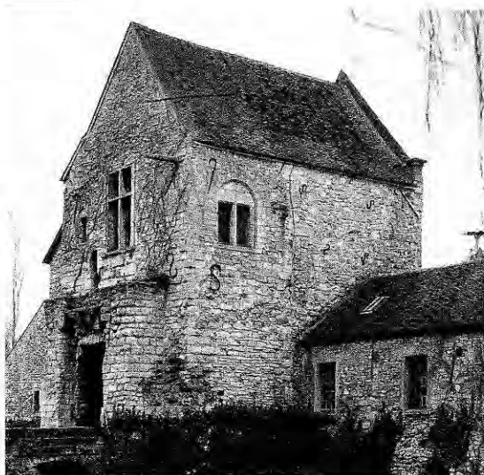
218. PONTARMÉ (Oise). Fenêtre de la tour-porte du château (XIII e siècle ?).
