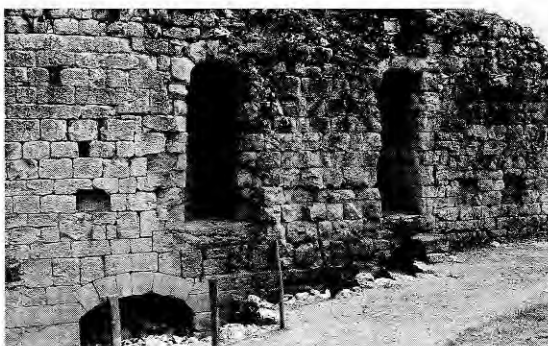
191. MOLIÈRES (Dordogne). Vue des entrées des deux latrines jumelées de la salle.
