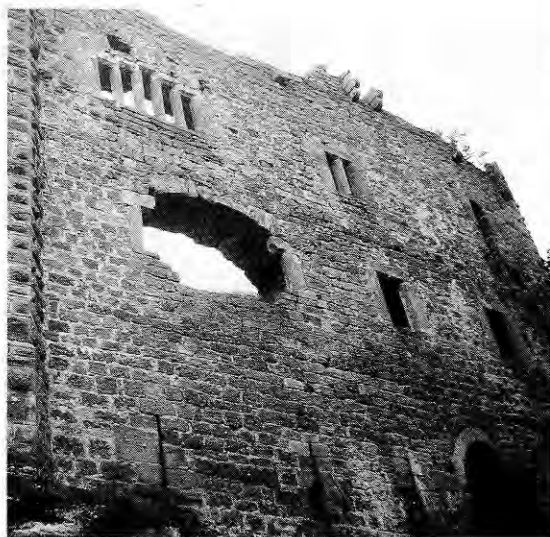
243. OTTROT (Bas-Rhin) : Château de Birkenfels. Logis XIII e siècle, avec des fenêtres rectangulaires à meneau, et aux deux étages nobles, des claires-voies à baies rectangulaires.
