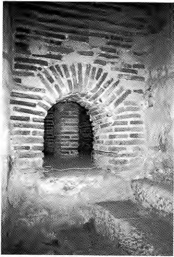
204. BRIDORÉ (Indre-et-Loire). Orifice d'entrée de l'hypocauste.
