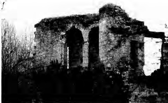
190. THIERS-SUR-THÈVE (Oise). Vue des latrines en encorbellement, à l'extrémité de la grande salle.
