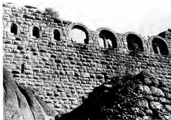
241. DAMBACH-LA-VILLE (Bas-Rhin) : Château de Bernstein. Fenêtres du logis du début XIII e siècle. Noter les jours à voussure et ébrasement externe, et les fenêtres à double cintre sous encadrement plein cintre.
