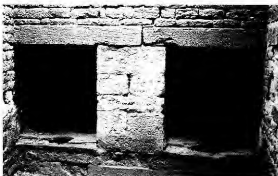
192. MARTAILLY-LÈS-BRANCION (Saône-et-Loire) : Château de Brancion. Latrine double attenante à la grande salle du XV e siècle.
