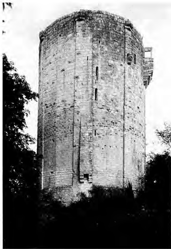
188. CHÂTILLON-COLIGNY (Loiret). Vue de la tour maîtresse des années 1180, avec la latrine s'intégrant dans un contrefort.
