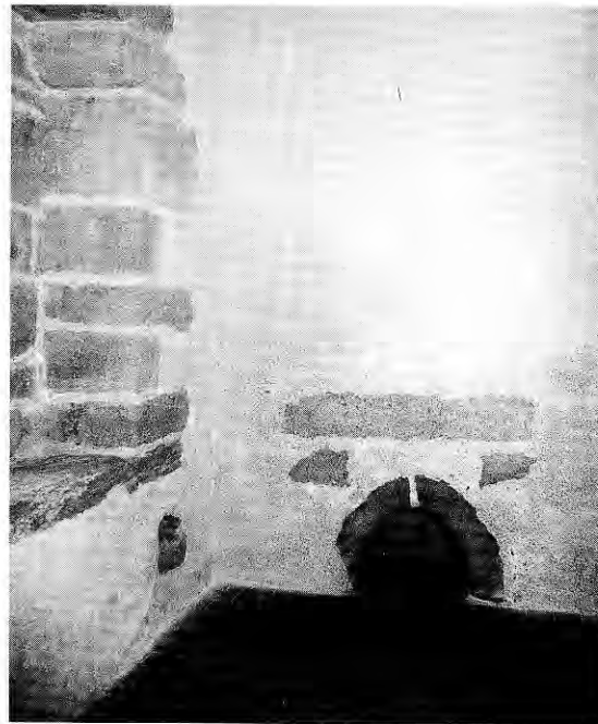
204. BRIDORÉ (Indre-et-Loire). Orifice d'entrée de l'hypocauste.
