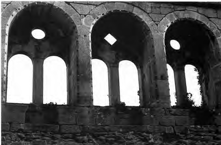
279. RIBEAUVILLÉ (Haut-Rhin) : Château de Saint-Ulrich. Fenêtres de la grande salle, de la première moitié du XIII e siècle. Noter les encoches latérales pour le scellement des gonds.
