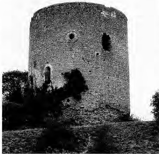
227. NEAUFLES-SAINT-MARTIN (Eure). La tour-résidence du XII e siècle, avec ses fenêtres en jour à voussure au premier étage, et ses oculi à l'étage noble.
