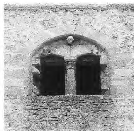
264. CHAMBOIS (Orne). Fenêtre de la tour-résidence de la fin du XII e siècle. Noter le décor particulier, et la présence derrière le tympan d'un linteau droit permettant la fermeture de volets.
