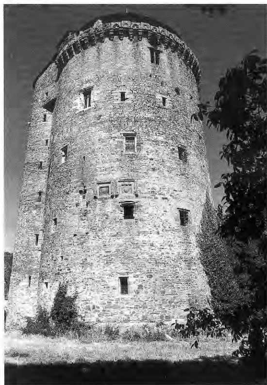
258. LE GRAND-FOUGERAY (Ille-et-Vilaine). La tour-résidence de la fin XIV e siècle, avec ses fenêtres à deux baguettes sur piédroits.
