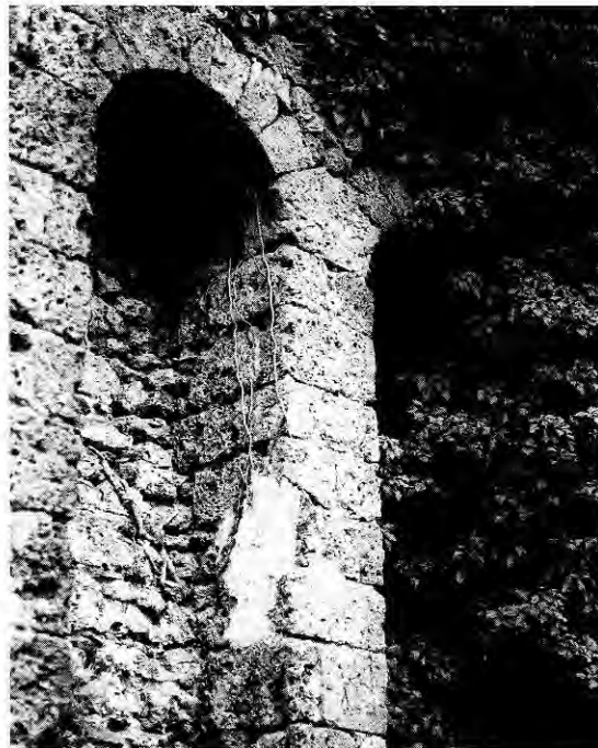
187. CHEVREUSE (Essonne). Latrines à conduit biais, de la première moitié du XII e siècle.
