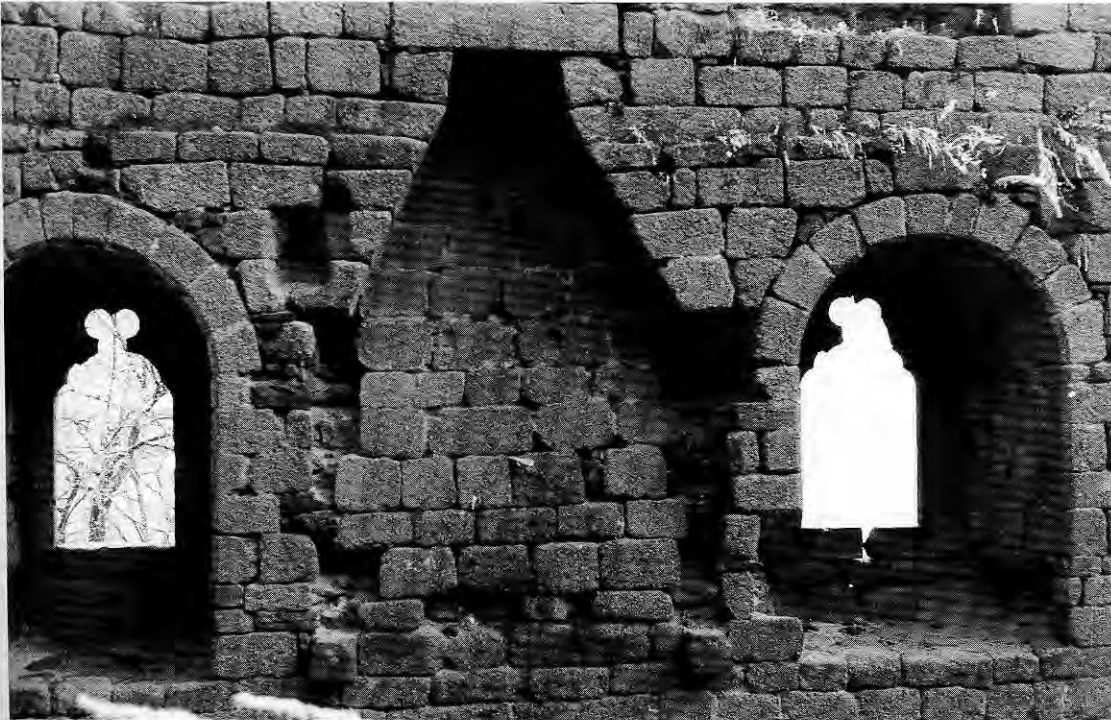
208. ANDLAU (Bas-Rhin). Fenêtres et cheminées du logis du XIV e siècle.
