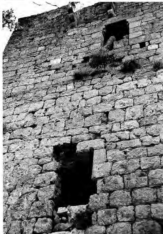
235. FRESSAC (Gard). Fenêtres du logis (fin XIII e ?). La fenêtre basse semble avoir été constituée de deux jours dans la même embrasure. Au-dessus fenêtre à deux coussinets à bosse, sans doute divisée en deux par un meneau primitivement.
