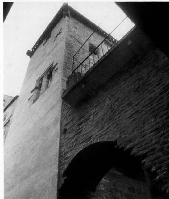
209. ALBAS (Lot). Vue d'une maison-tour privative.
