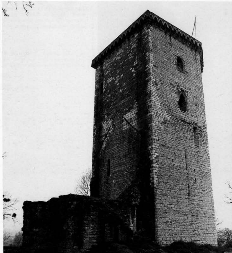
231. ORTHEZ (Pyrénées-Atlantiques). Les ruines de la salle et la tour maîtresse en éperon (en fuyante à droite). On reconnait facilement l'élévation primitive de la salle, marquée par la feuillure du toit sur la tour ; par ailleurs, on note la surélévation manifeste de la tour elle- même à compter du milieu de sa hauteur.
