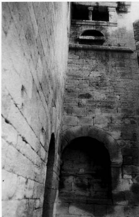
147. CHAMARET (Drôme). Vue de la paroi de la grande arcade d'entrée de la tour. A gauche en bas, l'entrée au rez-de-chaussée, avec une arcature ; au-dessus se trouvait un palier dont on reconnaît la console support, avec des dispositifs muraux semblant servir de « vestiaires ».
