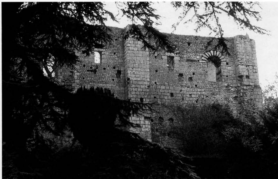
110. LANGEAIS (Indre-et-Loire). La tour-résidence , bâtiment résidentiel de la fin du XI e siècle transformé au XII e siècle en une tour seigneuriale par adjonction de contreforts. Noter les archivoltes sous fenêtres, de tradition gallo-romaine.
