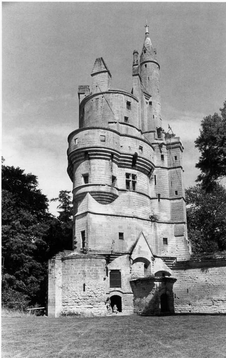
178. SEPTMONTS (Aisne). La tour maîtresse, vue de la cour. On notera le plan complexe de cet édifice, marqué en particulier par la protubérance de l'oratoire (ou chambre privée) à l'étage noble. Sur la droite, la tour de latrine flanque la vis qui se prolonge en guette au sommet. Noter enfin l'appendice rectangulaire à la base, abritant l'escalier de la cave, et au-dessus un balcon d'apparat (disparu).
