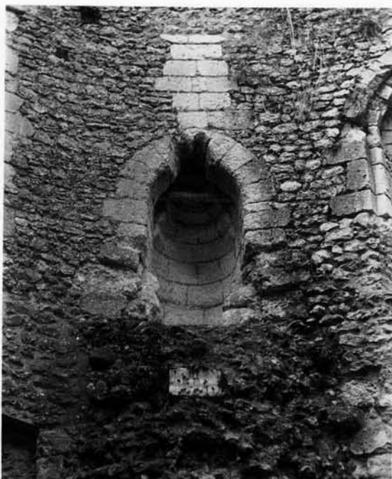
138. CONCHES-EN-OUICHE (Eure). Vue intérieure du puits ménagé dans l'épaisseur du mur de la tour de la fin du XII e siècle ; la niche du puits n'est accessible qu'au niveau de réception, au-dessus du stockage autrefois voûté.
