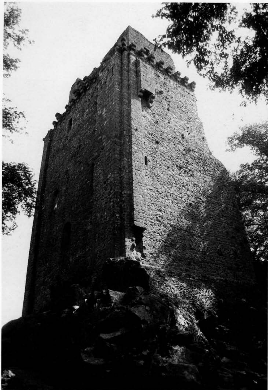
235. VIRE (Calvados). Un cas particulier de tour à contreforts de type B : l'un des contreforts contient le conduit de latrines.
