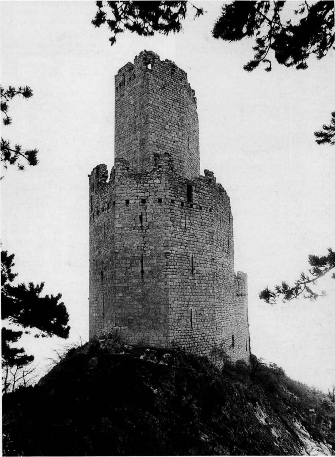
101. SCHERWILLER (Bas-Rhin). Château de l'Ortenberg. Tour-befroi pentagonale à éperon, bâtie vers 1260. Elle est protégée par une « chemise » pentagonale. Noter les trous de boulins des hourdages, à la fois au sommet du donjon et à celui de la chemise.
