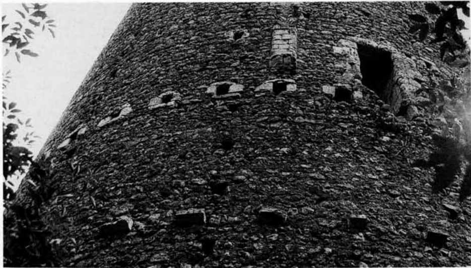
145. FRÉTEVAL (Loir-et-Cher). Vue de l'entrée de la tour du XI e siècle. On reconnaît les trous de boulin du balcon, les consoles servant de support aux contrefiches supportant le balcon. A gauche de la porte, on voit le montant d'une porte interrompant la galerie d'accès.
