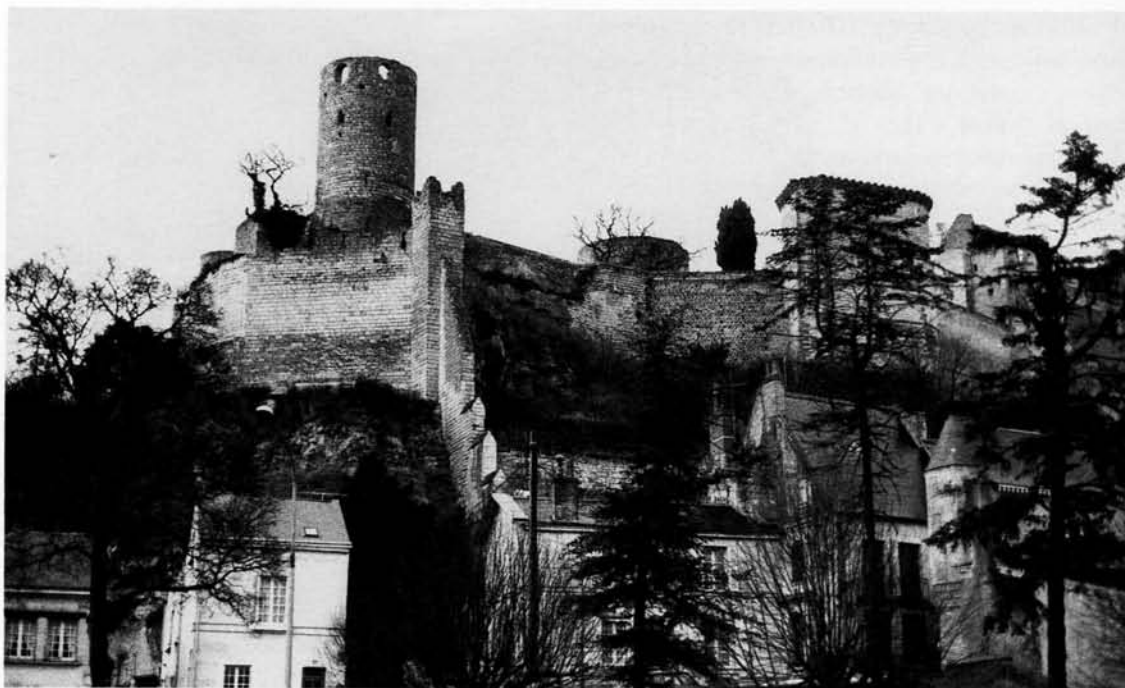
195. CHINON (Indre-et-Loire). La Tour du Moulin, oeuvre anglaise des années 1180. On y retrouve la symbolique des tours philippiennes , sans néanmoins identifier dans la tour de fonctions résidentielles.
