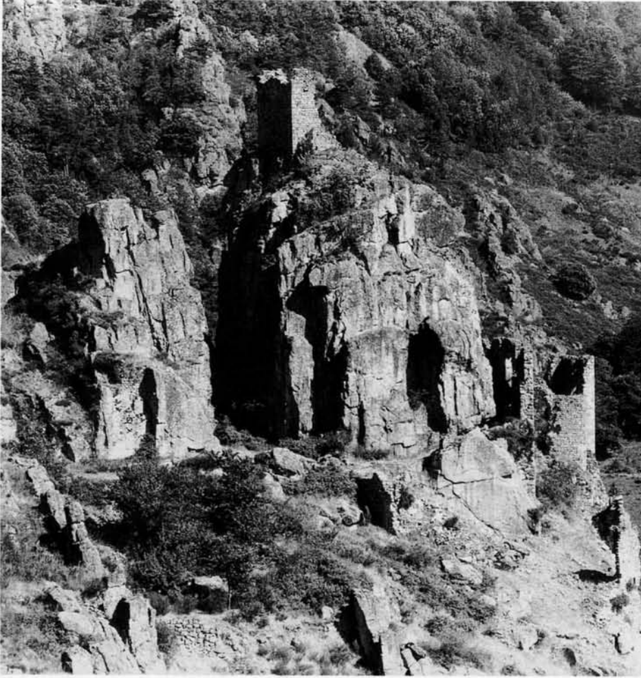
108. SAINT-MARTIN-DE-VALAMAS (Ardèche). Château de Rochebonne. Une tour-befroi en région montagneuse, au-dessus des logis du château établis contre la falaise.
