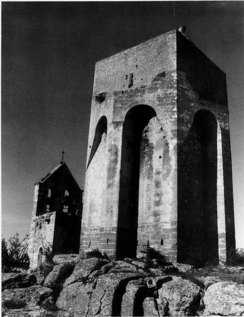
238. CLANSAYES (Drôme). La très curieuse tour, avec ses contreforts médians supportant des mâchicoulis en arcs. Les petits trous noirs à la base sont des meurtrières très frustes.
