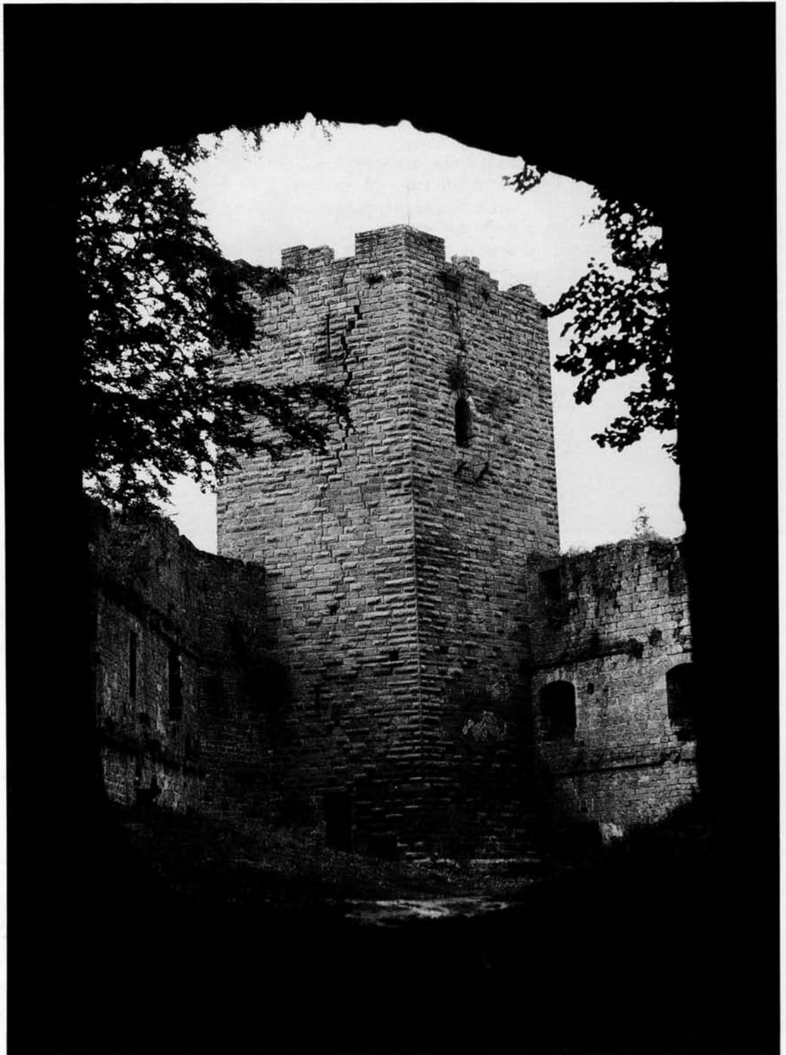
100. WANGENBOURG (Bas-Rhin). Tour-beffroi pentagonale, dotée d'archères cruciformes, construite dans la seconde moitié du XIV e siècle.
