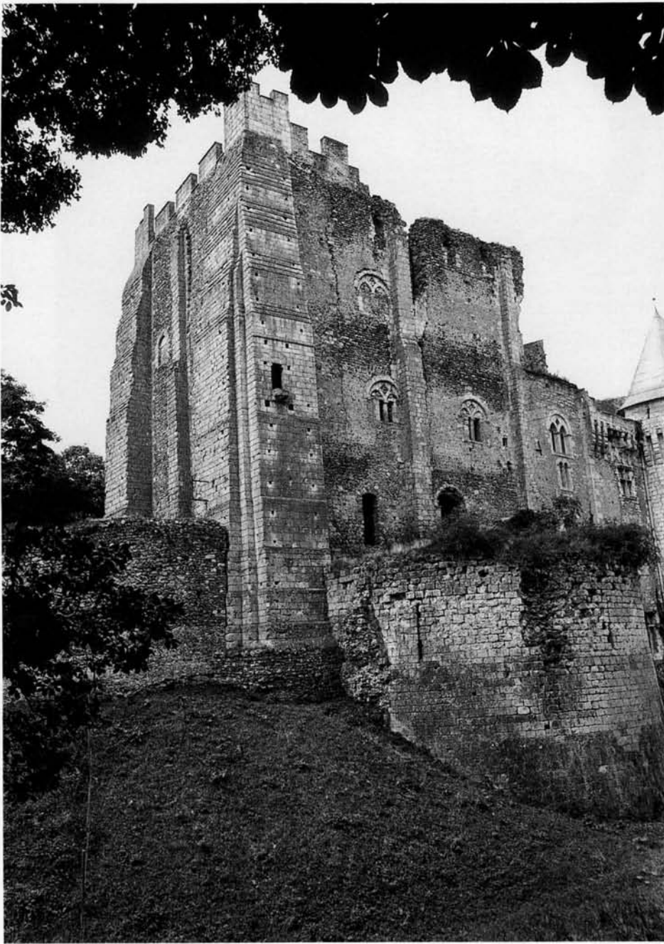
130. NOGENT-LE-ROTROU (Eure-et-Loir). Vue extérieure de la tour. Au-devant, flanquement du XIII e siècle. Noter, dans le contrefort le plus proche, la porte de la latrine en encorbellement disparue.
