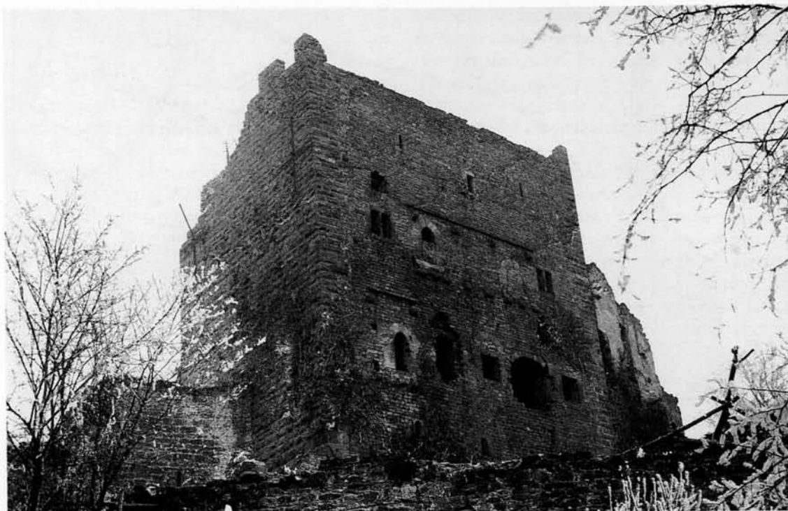
113. OTTROT (Bas-Rhin), château de Ratsamhausen. Tour-résidence du début du XIII e siècle. Noter, au niveau intermédiaire, les trous de boulin et le faitage du balcon qui reliait les deux portes encore visibles sur la façade.
