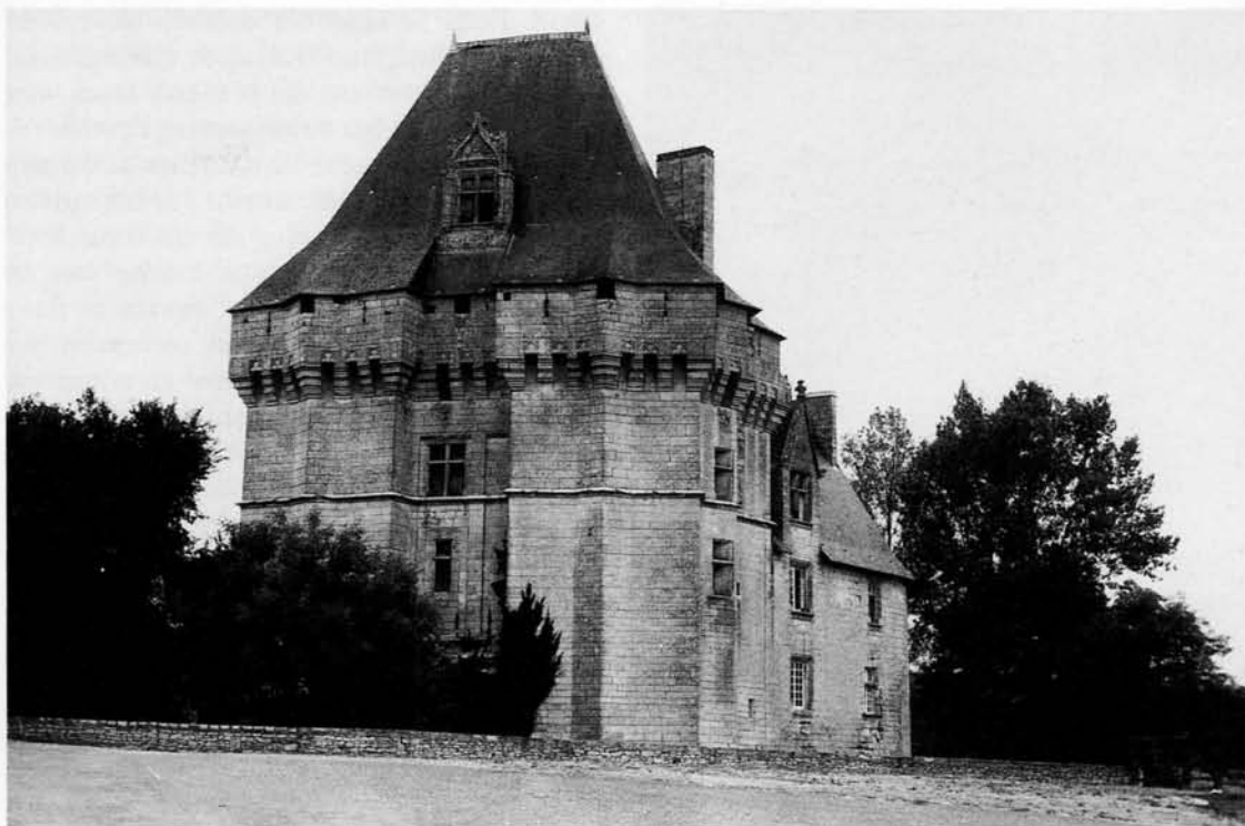
245. CERVEUX (Deux-Sèvres). La tour maîtresse, très tardive puisque postérieure à 1476, est flanqué par de curieux contreforts polygonaux à saillants et rentrants.
