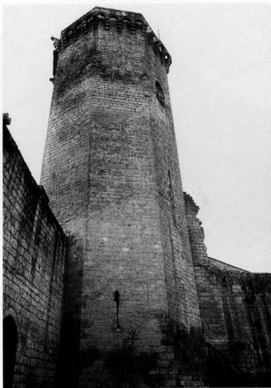
203. BOURDEILLES (Dordogne). La tour octogonale bâtie à la fin du XIII e siècle. On remarque aux deux premiers niveaux des archères à étrier, et au-dessus une fenêtre marquant la salle noble.
