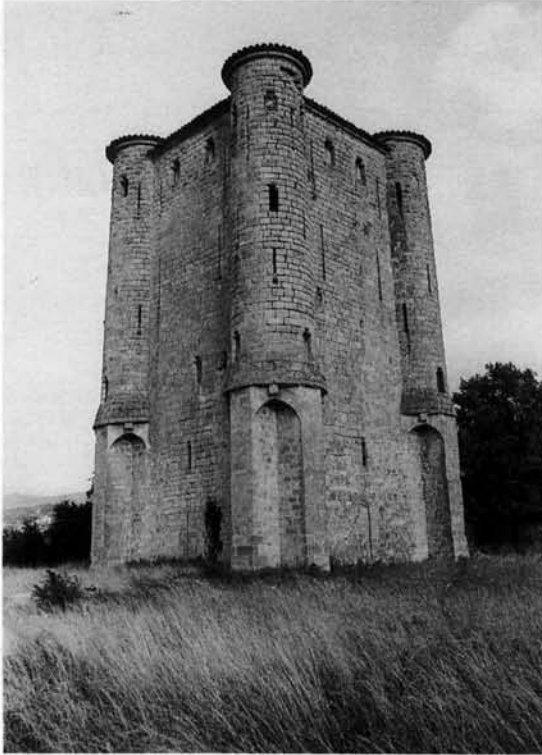
246. ARQUES (Aude). La tour maîtresse, tour-mixte bâtie à la fin du XIII e siècle. La tour est flanquée par quatre tourelles reposant sur des contreforts ; les trompes cachent des assommoirs.
