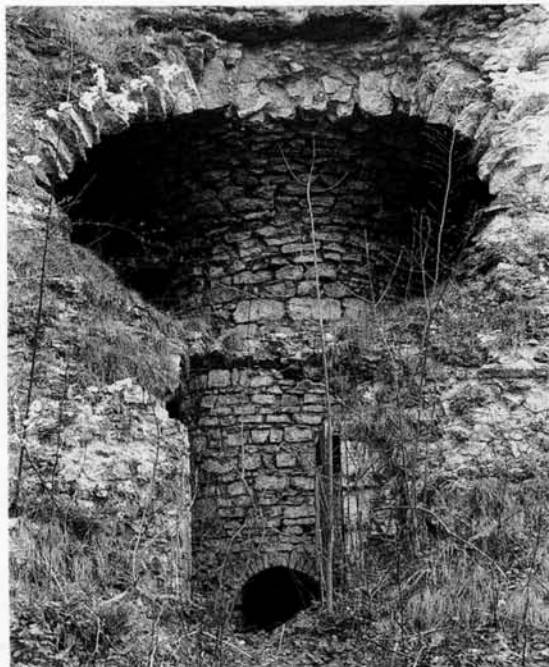
137. LES MONTILS (Indre-et-Loire). Vue de la ruine de la tour, montrant la voûte et le pilier du niveau bas de la tour. Le pilier est creux, le puits prenant place en son centre ; on voit le puisard.
