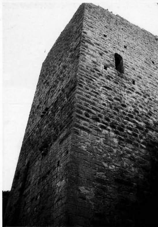
145. FRÉTEVAL (Loir-et-Cher). Vue de l'entrée de la tour du XI e siècle. On reconnaît les trous de boulin du balcon, les consoles servant de support aux contrefiches supportant le balcon. A gauche de la porte, on voit le montant d'une porte interrompant la galerie d'accès.
