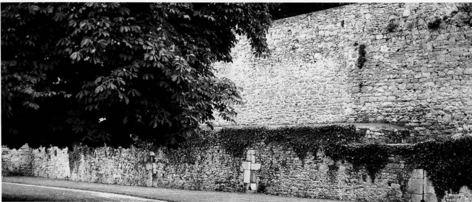
306. DINAN (Côtes-d'Armor). Fausse-braie garnissant l'enceinte urbaine. Cet ouvrage doté de longues archères-canonnières pourrait être l'un des derniers aménagements de l'enceinte au XV e siècle, en tout cas postérieur à la construction des tours par le duc François II.
