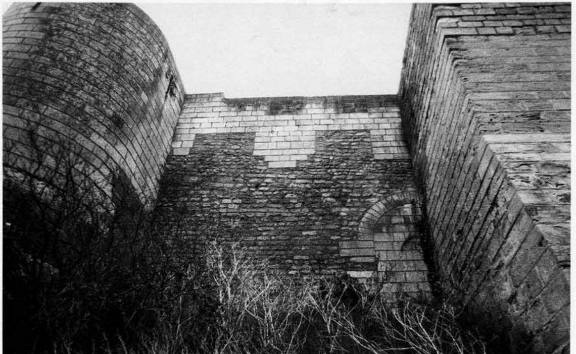
267. CHINON (Indre-et-Loire). Courtine primitive du château du Coudray, édiflée au début du XI e siècle. On reconnaît aux deux tiers de la hauteur le crénelage primitif, et à la base une ancienne porte rebouchée lors de la construction de la tour carrée au XII e siècle.
