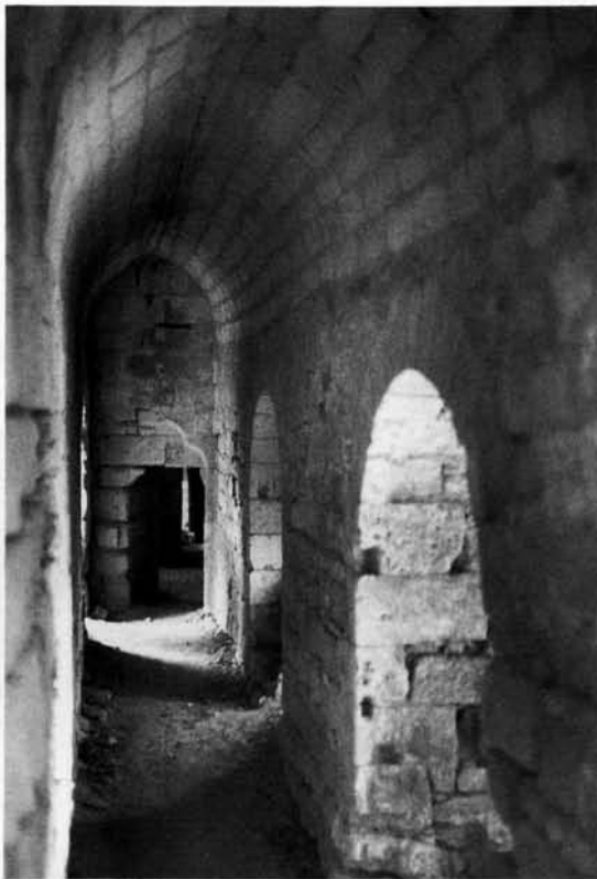
292. ÉCHIRÉ (Deux-Sèvres). Château du Coudray-Salbart. Vue intérieure de l'une des sections de galeries voûtées, avec ses embrasures d'archères.
