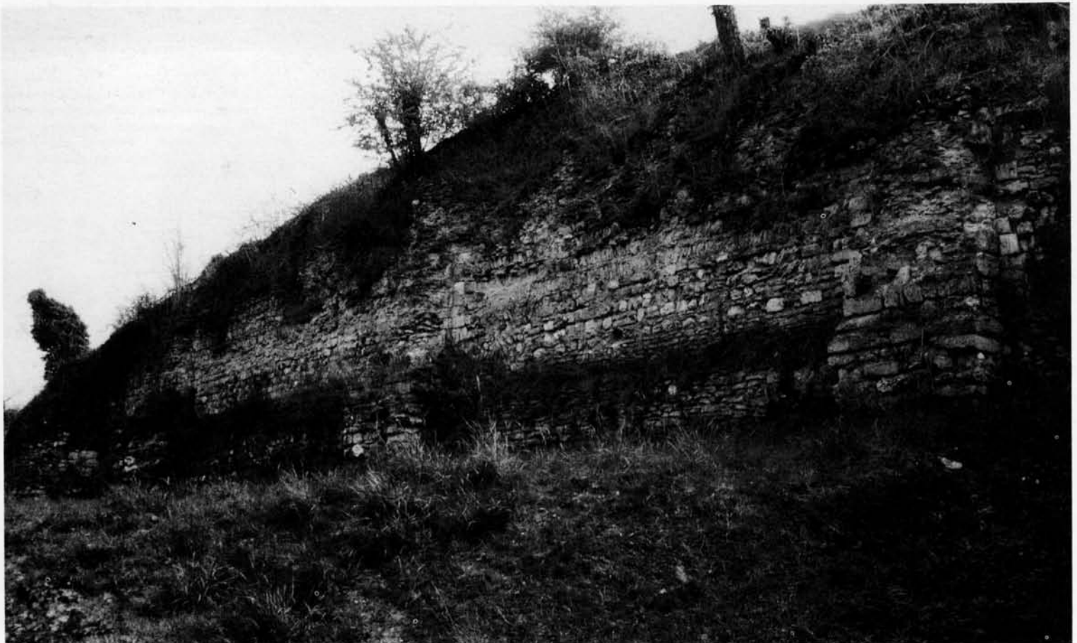
281. IVRY-LA-BATAILLE (Eure). Front de l'enceinte du XI e siècle, avec ses contreforts raidissant les courtines.
