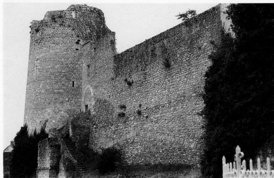
271. YÈVRE-LE-CHATEL (Loiret). Courtine d'entrée du château, avec son grand arc segmentaire bandé entre les deux tours de flanquement.
