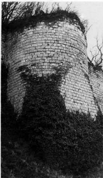
375. CHINON (Indre-et-Loire). Tour à talus angevin sur le front Nord du château.
