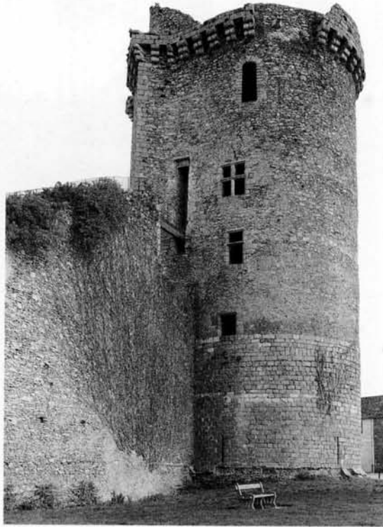
330. BLANDY-LES-TOURS (Seine-et-Marne). Vue de la Grosse Tour, bâtie dans le dernier quart du XIV e siècle. Noter la différence d'appareil entre la base de la tour, défensive, et les parties supérieures, résidentielles, qui devaient être crépites. Noter également le pont-levis à bascule qui isolait la tour du chemin de ronde.
