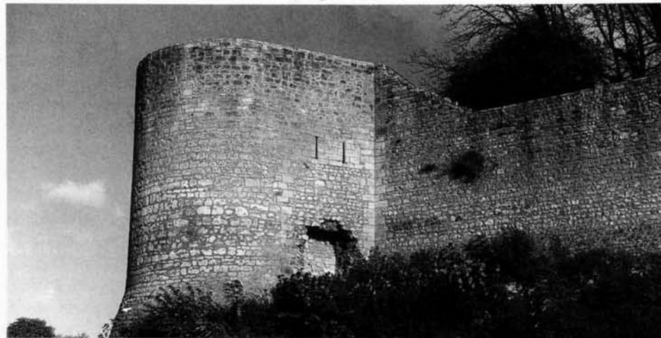
313. GISORS (Eure). Vue de l'une des tours flanquantes bâties sous le règne d'Henri II d'Angleterre. Noter l'archère double à fente courte.
