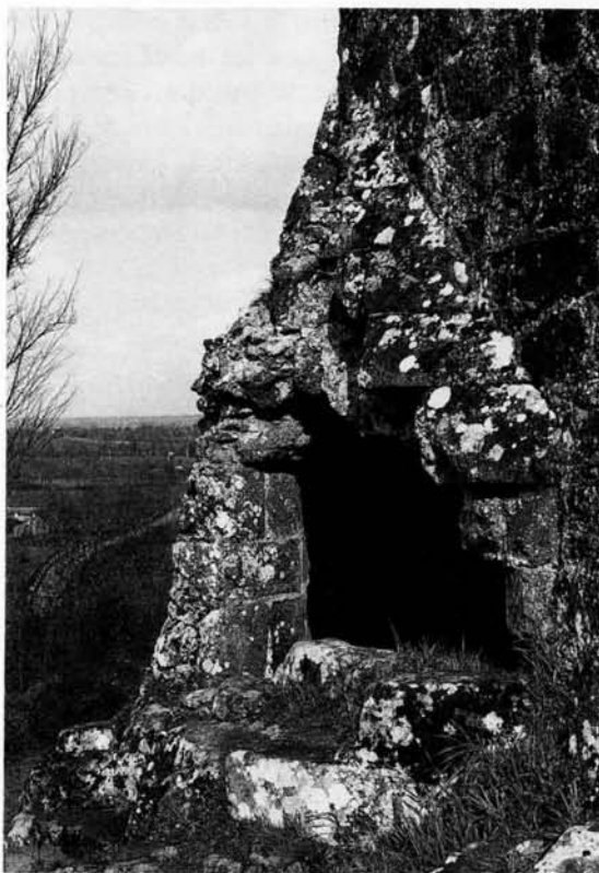
348. HÉDÉ (Ille-et-Vilaine). Vue de l'un des moineaux de l'enceinte. Aujourd'hui éventré à l'endroit où se trouvait une canonnière, il donne accès à un escalier menant vers l'intérieur de la place.
