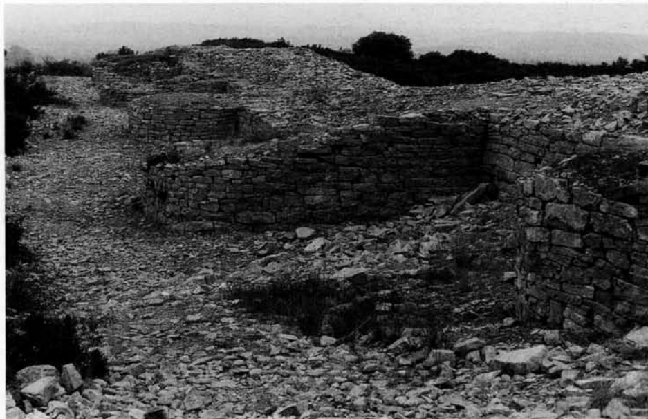
307. VILLETTELLE (Hérault). Oppidum d'Ambrussum. L'enceinte de cette cité préromaine, bâtie entre 250 et 175 avant notre ère, est flanquée par des tours semi-circulaires en U.
