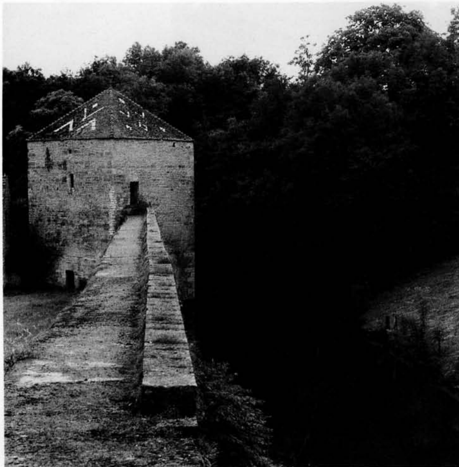
357. MARIGNY-LE-CAHOUËT (Côte-d'Or). L'une des tours rectangulaires placées suivant la diagonale du rectangle de l'enceinte.
