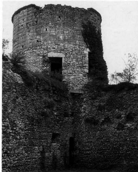
362. DORDIVES (Loiret). Château de Mez-le-Maréchal. Angle interne de l'enceinte, avec la tour flanquante dont le plan circulaire se rattrape par le biais d'une trompe.
