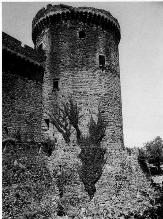
341. SAINT-FARGEAU (Yonne). Plan du château montrant l'enchemisement des tours primitives du XIII e siècle pour les transformer en tours à canon, dotées de contremines.
