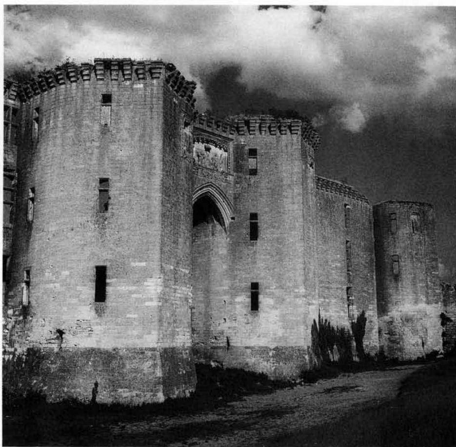
331. LA FERTÉ-MILON (Aisne). Vue de la façade du château construit entre 1396 et 1410 par Louis d'Orléans. Les tours y présentent un plan semi-circulaire avec éperons en accolade.
