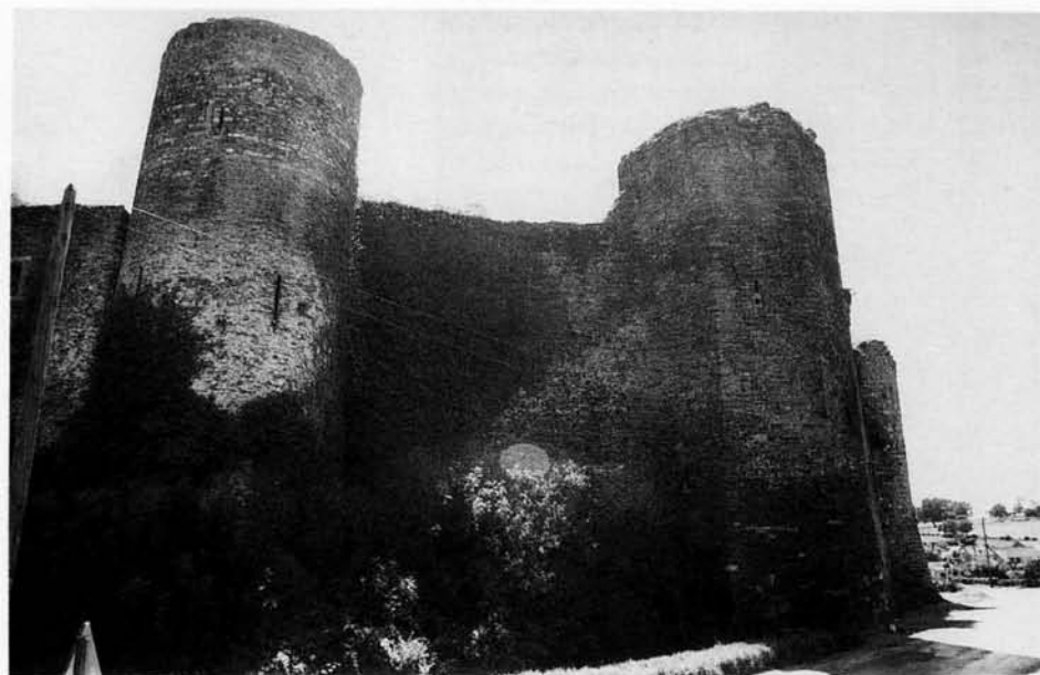
349. POUANCÉ (Maine-et-Loire). Tour pentagonale à canon de la fin du XV e siècle. La tour possédait quatre niveaux de défense, dont trois à canonnières formées d'un orifice circulaire et d'une fente de visée.
