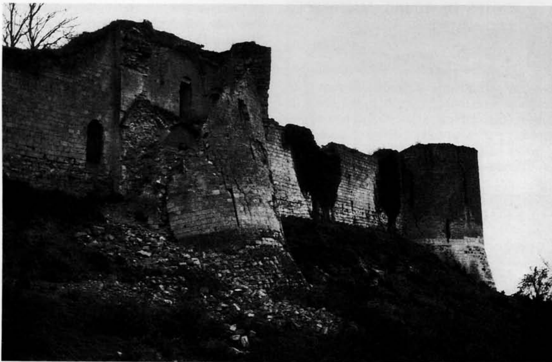
450. COUCY (Aisne). Une poterne ménagée dans la courtine de la basse-cour au XIII e siècle, sous la surveillance d'une tour circulaire à archères en rame.
