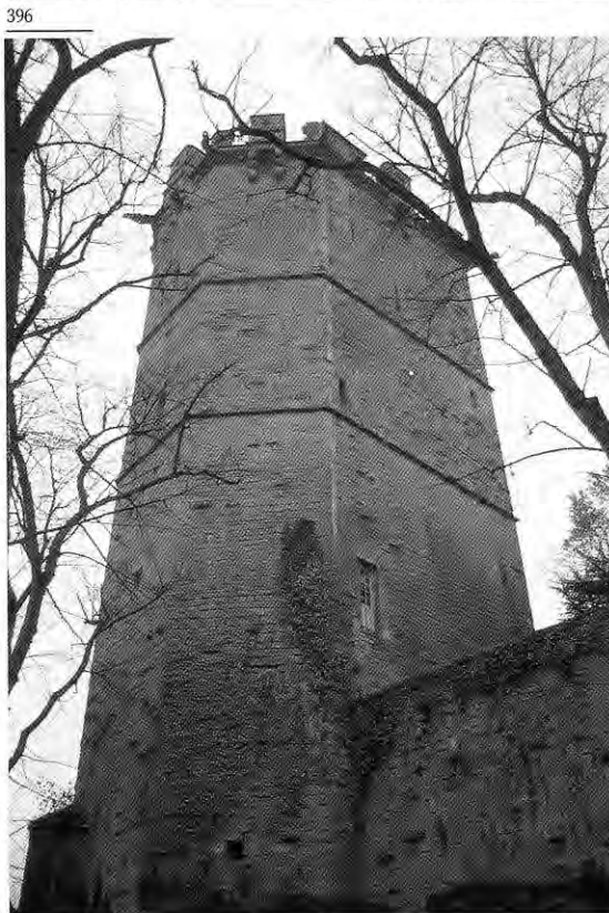
397. MONTBARD (Côte-d'Or). Tour maîtresse des années 1300, à parement à bossages rustiques épars ; le chemin-de-ronde en est doté de bretèches discrètes (comparer à Aigues-Mortes).
