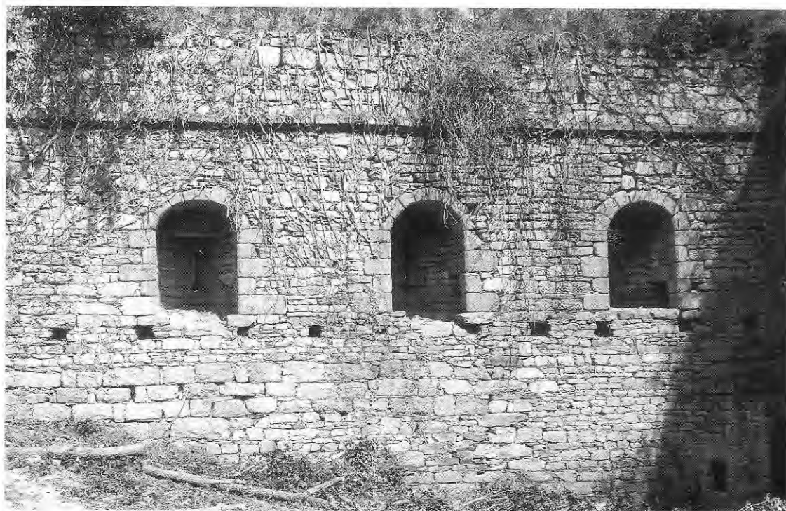
380. PLOUBEZRE (Côtes-d'Armor) : Château de Coëtfrec. Courtine à canon- nières postérieure à 1460. Chacune des niches est dotée d'un abri pour tireur.
