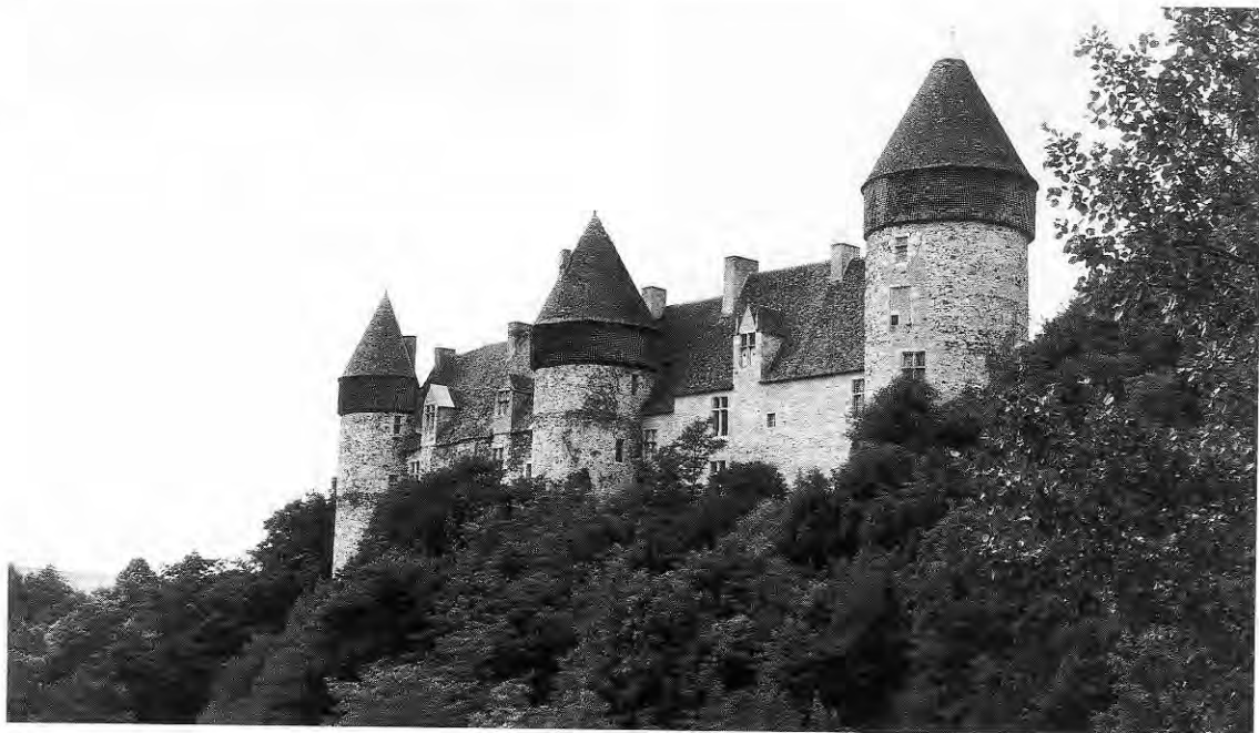
399. CULAN (Cher). Les tours hourdées du château. Le hourdage date vraisemblablement du XV e siècle ; il se caractérise, comme tous les hourds conservés, par une très faible ouverture horizontale, et par une assez faible saillie.
