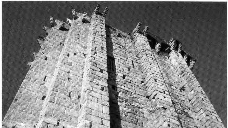
412. SAUGUES (Haute-Loire). Tour-résidence à contreforts dotée tardivement d'une couronne de mâchicoulis ; comme au bâtiment des Mâchicoulis du Puy, la difficulté de ceinturer les contreforts par les mâchicoulis en arcs sur consoles a conduit les constructeurs à ménager sur chacun d'eux de petites bretèches.
