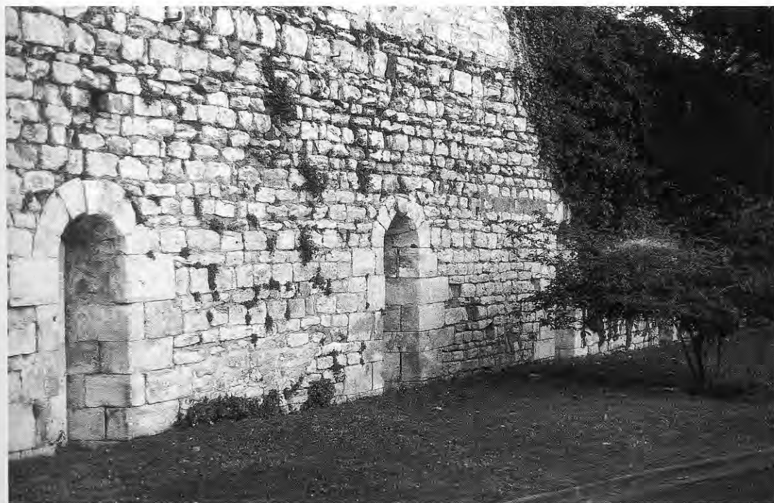
333. NEVERS (Nièvre). Vue de la courtine bâtie par Pierre de Courtenay peu avant 1200, avec ses archères à évasement, desservies par une gaine interne.
