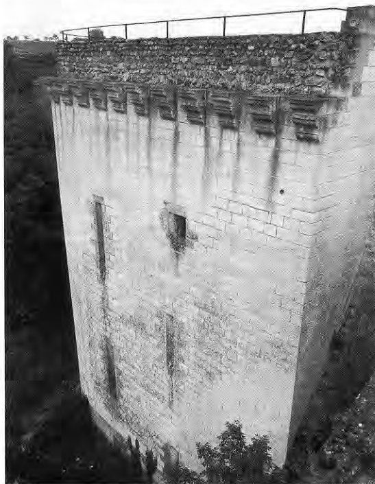
386. CHINON (Indre-et-Loire). Tour d'Argenton, bâtie à la fin du XV e siècle. Les ouvertures de tir, longues et ébrasées extérieurement, ne comportent aucun orifice spécifique, interrogeant sur l'utilisation d'armes de petit calibre, et plus loin sur l'usage qui fut fait des fentes de canonnières.
