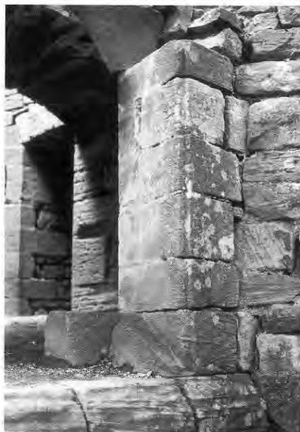
312. NAJAC (Aveyron). Vue d'une des tours du château, avec ses archères de très grande taille. Cette photo laisse apercevoir, derrière la fente, le subterfuge constructif qui consista à ménager une archère de grande hauteur apparente devant une fenêtre de tir n'y correspondant pas, dans le seul but d'impressionner l'assaillant.
