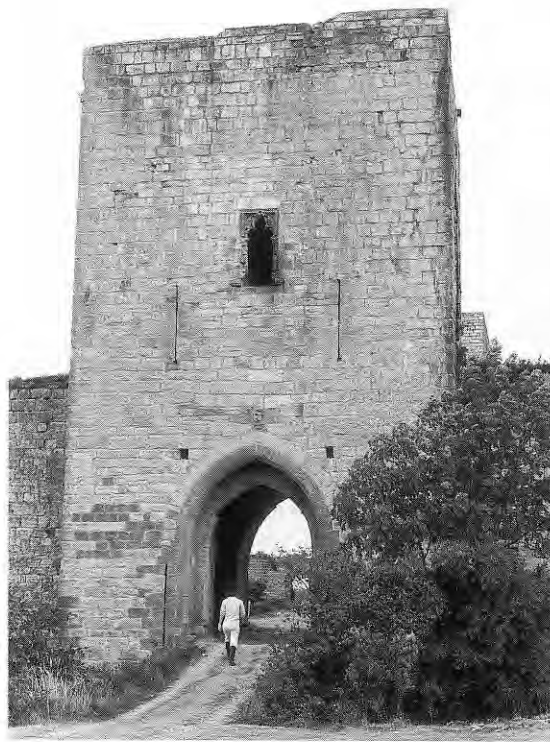
353. PUIVERT (Aude). Tour-porte d'entrée de la basse-cour (début XIV e siècle), munie d'archères à étrier carré. Le château présente également des archères à étrier triangulaire.
