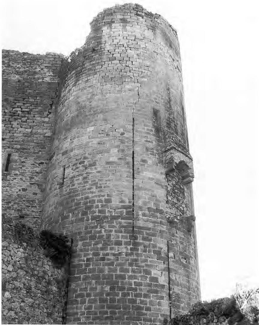
312. NAJAC (Aveyron). Vue d'une des tours du château, avec ses archères de très grande taille. Cette photo laisse apercevoir, derrière la fente, le subterfuge constructif qui consista à ménager une archère de grande hauteur apparente devant une fenêtre de tir n'y correspondant pas, dans le seul but d'impressionner l'assaillant.
