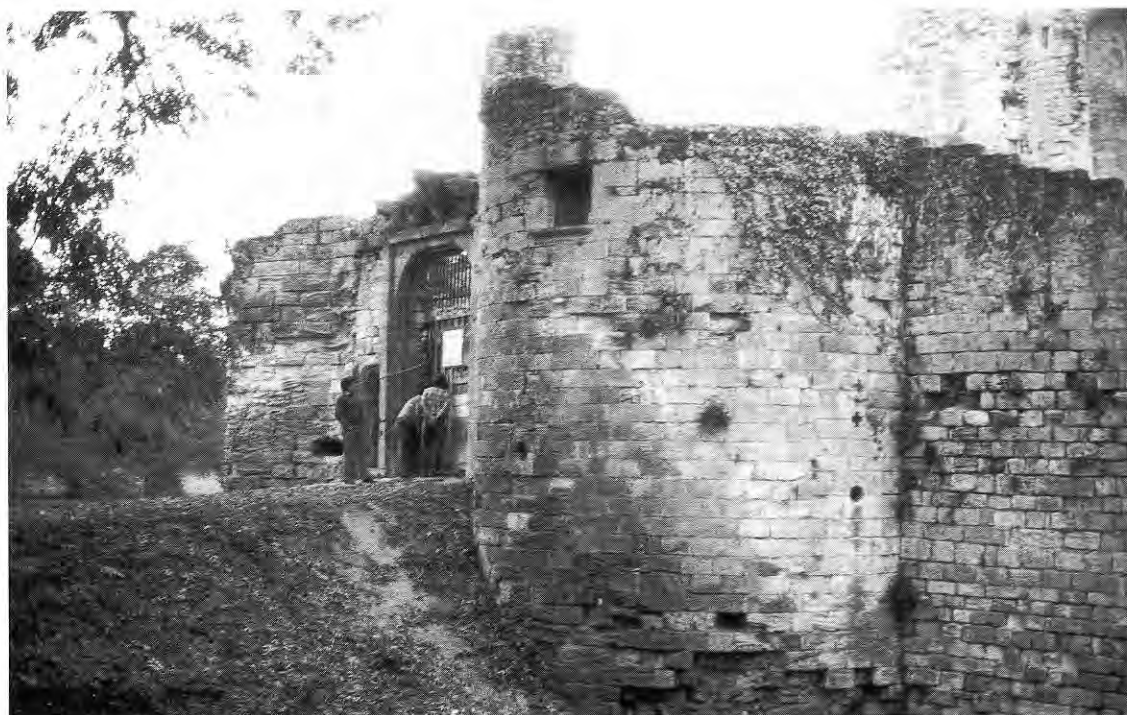
388. NEVERS (Nièvre). Tour Saint-Révérien (anciennement tour du Hâvre), datée de 1459-60, avec des canonnières à fente courte (aération et visée) disjointe de l'orifice de tir.
