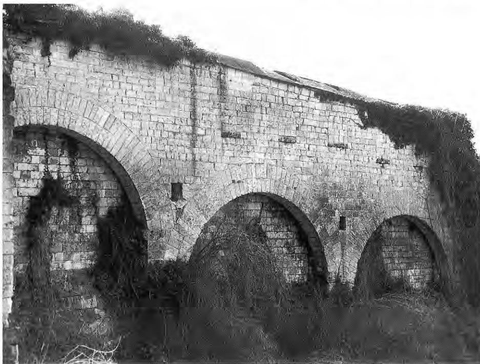
408. LUCHEUX (Somme). Mâchicoulis en arcs sur contreforts, remarquablement appareillés, datés de la fin du XII e siècle.
