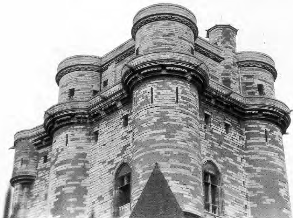
417. VINCENNES (Val-de-Marne). Tour-résidence du château royal, bâtie entre 1360 et 1370. Vue des mâchicoulis ménagés dans un encorbellement décoratif.
