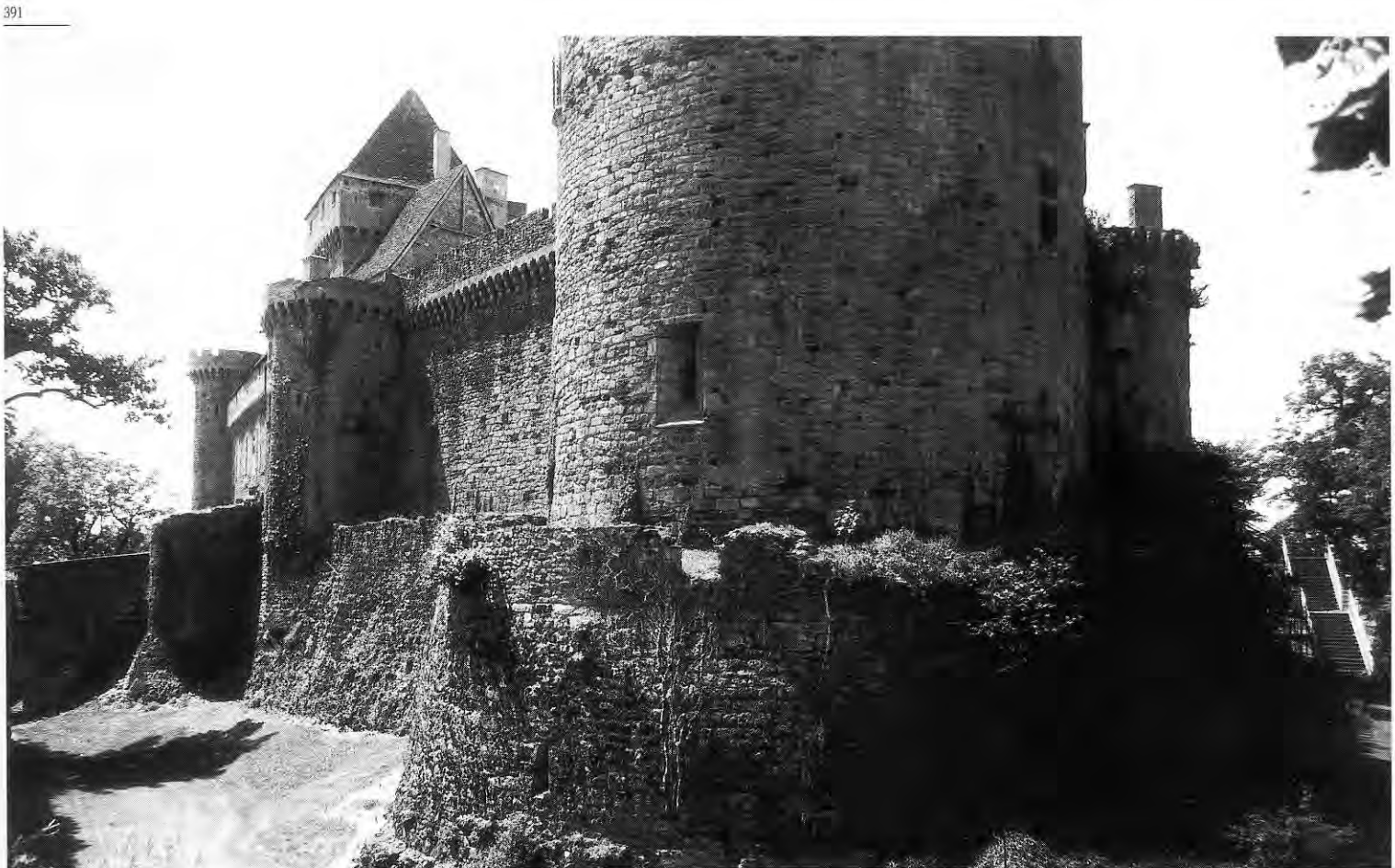
391. PRUDHOMAT (Lot) : Château de Castelnau-Bretenoux. La tour militaire, avec ses canonnières à ébrasement externe de facture curieuse, se situant entre les canonnières à la française abouties, et les canonnières à fente classiques.
