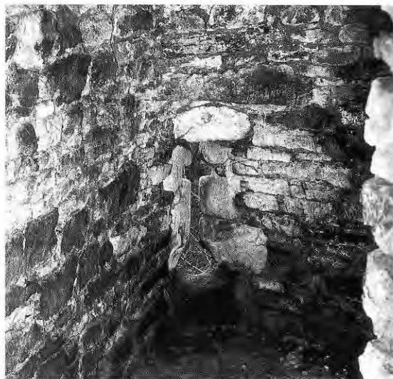
382. DINAN (Côtes-d'Armor). Tour de Penthievre, vers 1470. Vue intérieure d'une chambre et de sa canonnière placée au sol.
