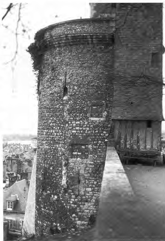
347. BLOIS (Loir-et-Cher). Tour du Foix (XIII e siècle ?). On note la présence d'archères à étriers à tous niveaux : au niveau inférieur, les étriers sont triangulaires, alors qu'ils sont rectangulaires surmontés d'un demi-cercle au-dessus.
