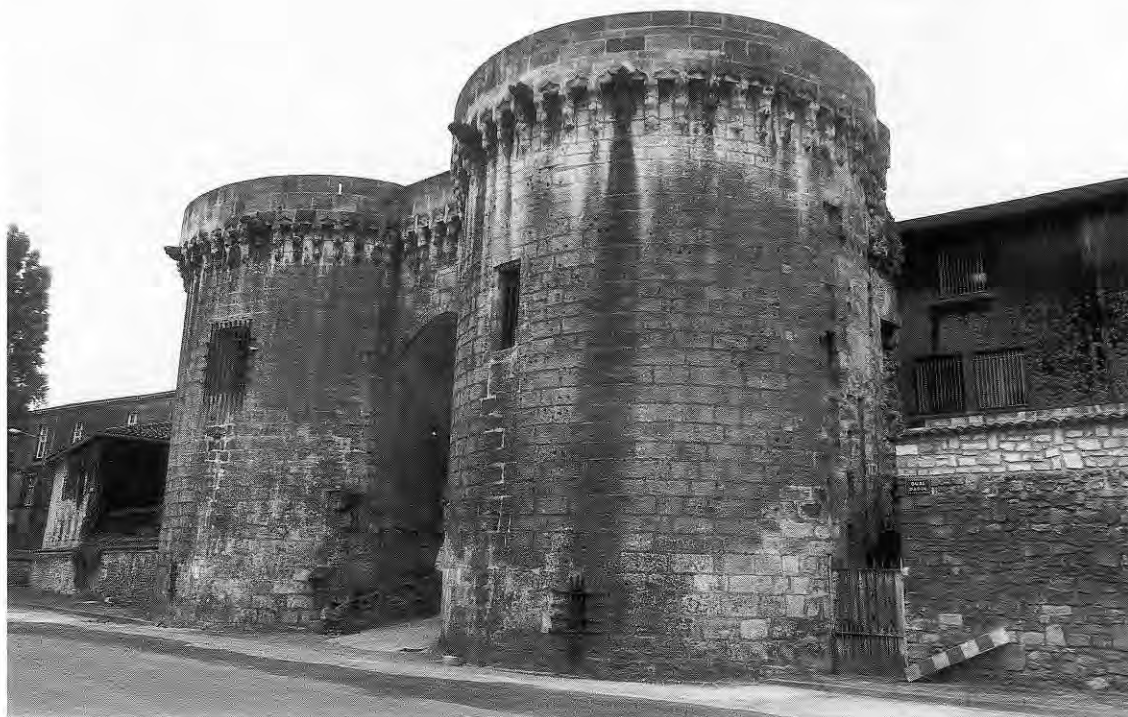
427. COMBOURG (Ille-et-Vilaine). Seconde variante de décor de linteaux : trilobes délardés dans un arc brisé à pointe amorçant une accolade, datable de la fin du XV e siècle, au-dessus de consoles bretonnes fortement moulurées. Noter le parapet du chemin de ronde doté de petites canonnières circulaires destinées au tir des arquebuses.
