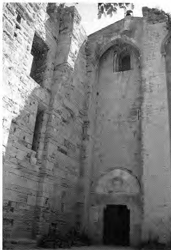
407. MAGUELONNE (Hérault). Façade de la cathédrale : à gauche la tour dite de la cuisine. La fortification par des mâchicoulis en arcs n'est sans doute pas attribuable aux campagnes originelles, de la fin du XII e siècle, qui ont marqué l'exécution du portail (1178) ; de la même façon, les mâchicoulis en arcs sur contreforts de la tour de cuisine datent vraisemblablement du milieu du XIV e siècle au plus tôt.
