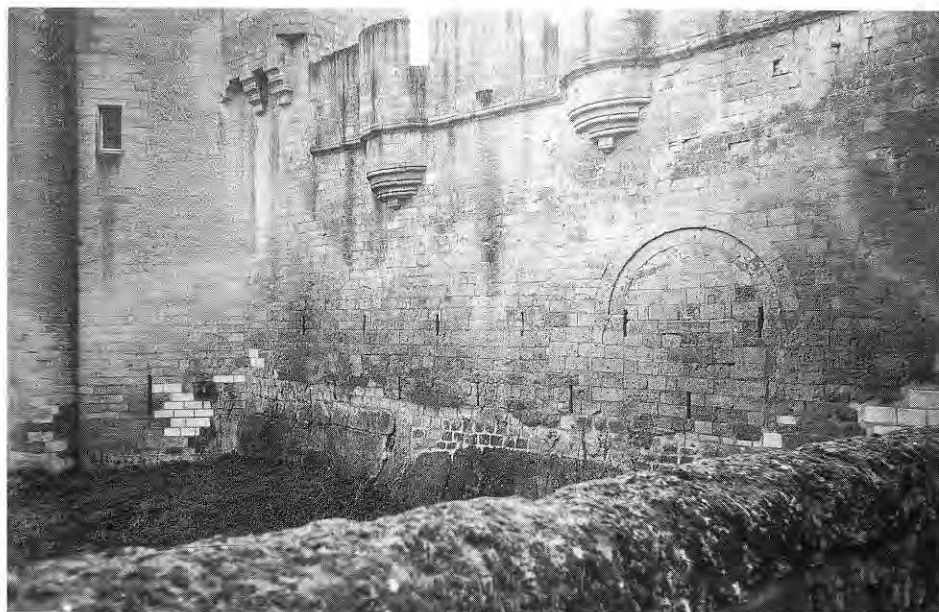
334. VEZ (Oise). Vue de la courtine du XV e siècle percée de petites embrasures sans ébrasement interne.
