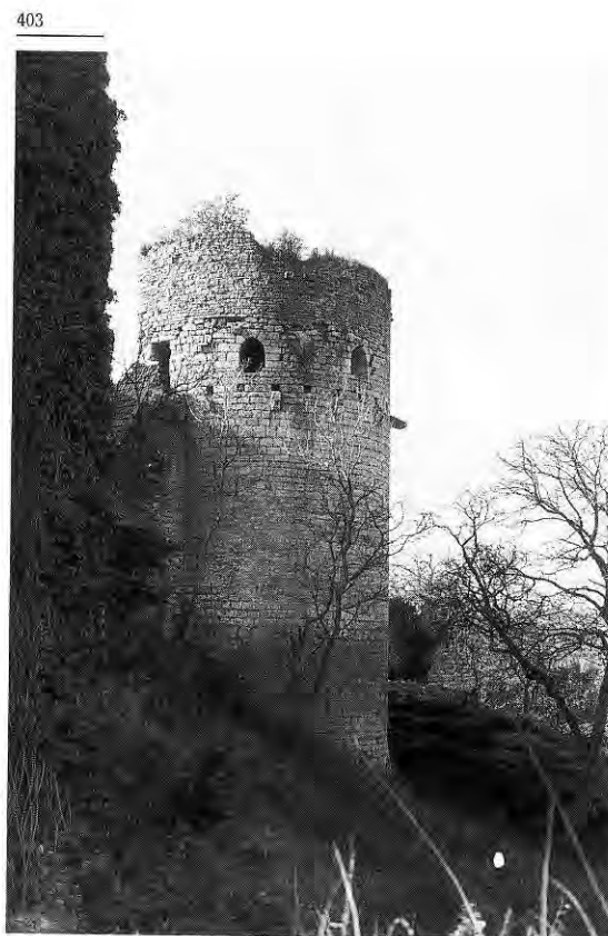
403. LUTHENAY-UXELOUP (Nièvre). Château de Rozemont. Vue de l'une des tours, dont le couronnement est encore conservé, avec les trous de boulin dotés une fois sur deux d'une console pour le hourdage, et le crénelage couvert d'arcs brisés, le tout étant d'une inspiration très proche de la tour maîtresse de Coucy, sans pourtant que l'on puisse y voir une influence réciproque.
