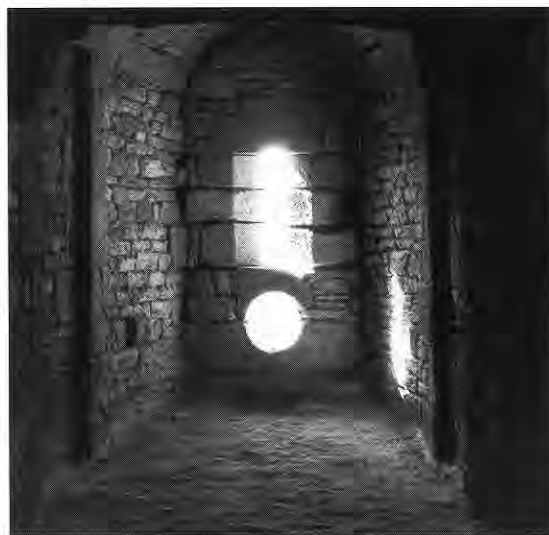
379. SARZEAU (Morbihan) : Château de Suscinio. Niche de canonnière dans la tour neuve de Jean V (avant 1437). Noter la présence de l'abri pour tireur sur le côté, et, dans les flancs de l'ébrasement, le logement de la poutre servant pour supporter les armes et en absorber le recul (cf. fig. 371).
